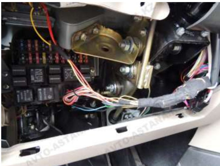
Фото 25. Вид блока предохранителя.
